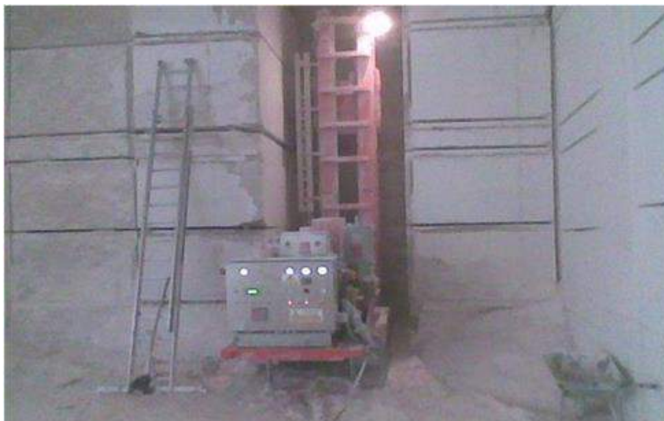
Slika 1./5. Piljenje zadnje stranice blokova lančanom sjekačicom
